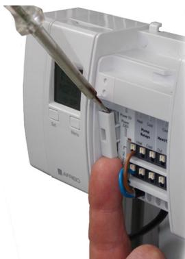
2. Извлеките держатель предохранителя.
